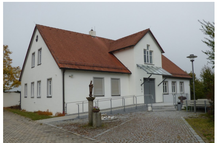
Das neue Pfarrheim wurde 1990 seiner Bestimmung übergeben und gesegnet.
