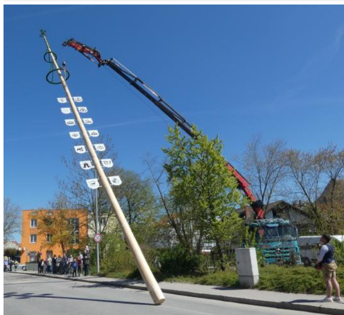
Gekonnt brachte der Kran der Firma Werra-Bau den mächtigen Baum vor mehreren hundert Zuschauern in die Senkrechte und zu seinem vorgesehenen Platz.
