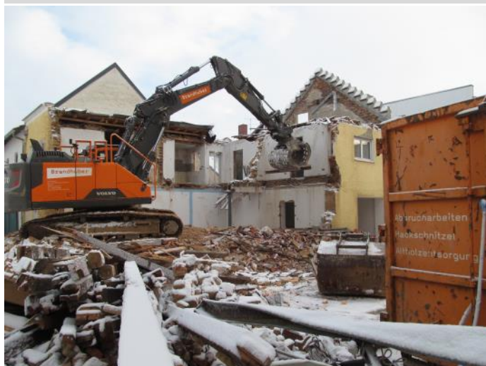
Das Gebäude des ehemaligen Textilgeschäftes Degner am Kirchplatz 3 wird bereits abgebrochen.
