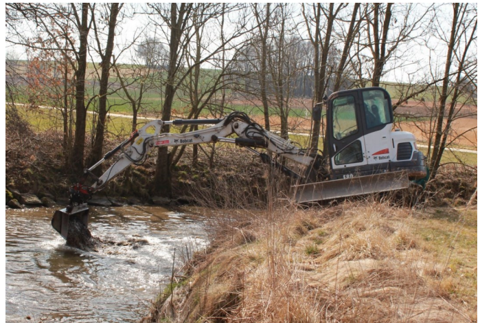
Mit einem Bagger wurde der Kiesboden umgewälzt und aufgelockert.
