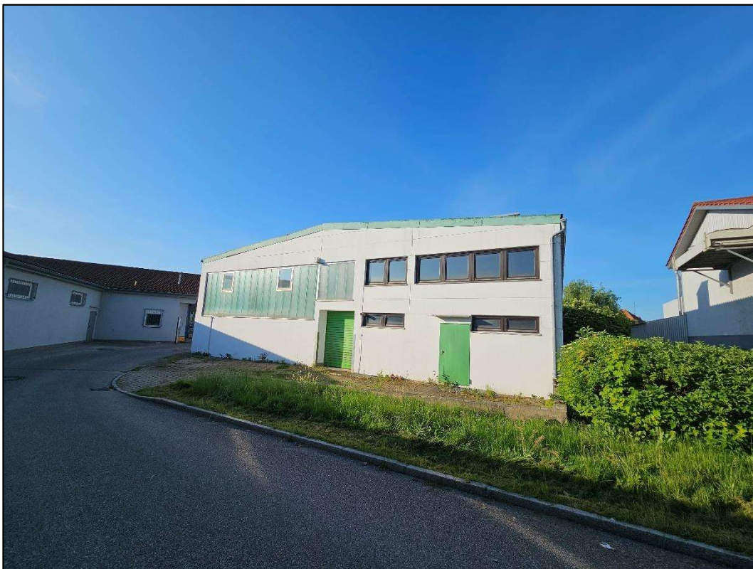
Abbildung 28: Nordseite des Baumarktes. Blick Richtung SSO.
