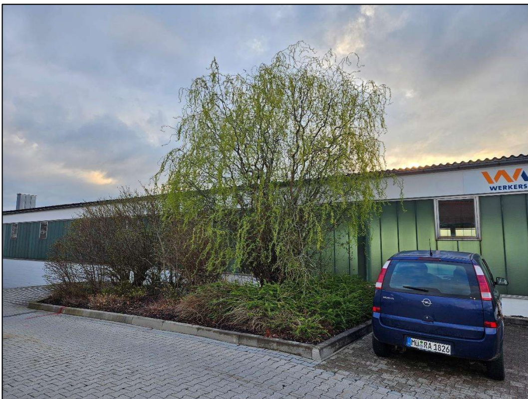
Abbildung 20: Westseite des Baumarktes vom Penny-Parkplatz fotografiert. Blick Richtung Nordosten.
