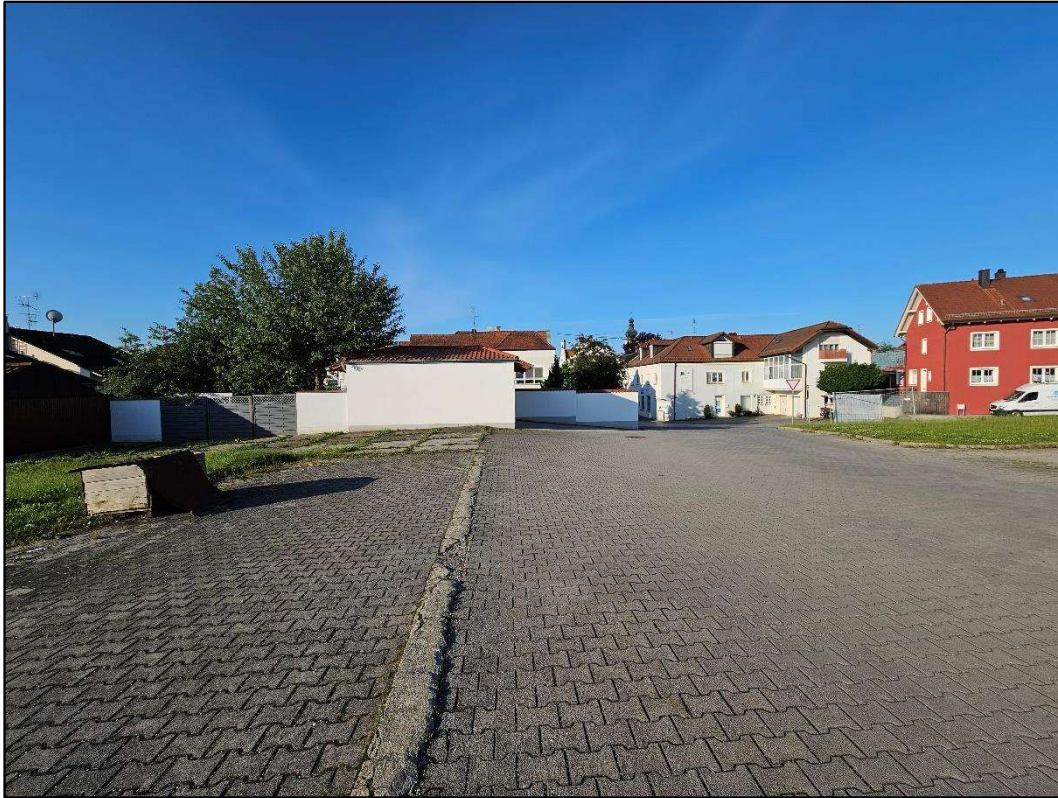
Abbildung 5: Südliche Zufahrt zum UG mit Blick Richtung Süden.
