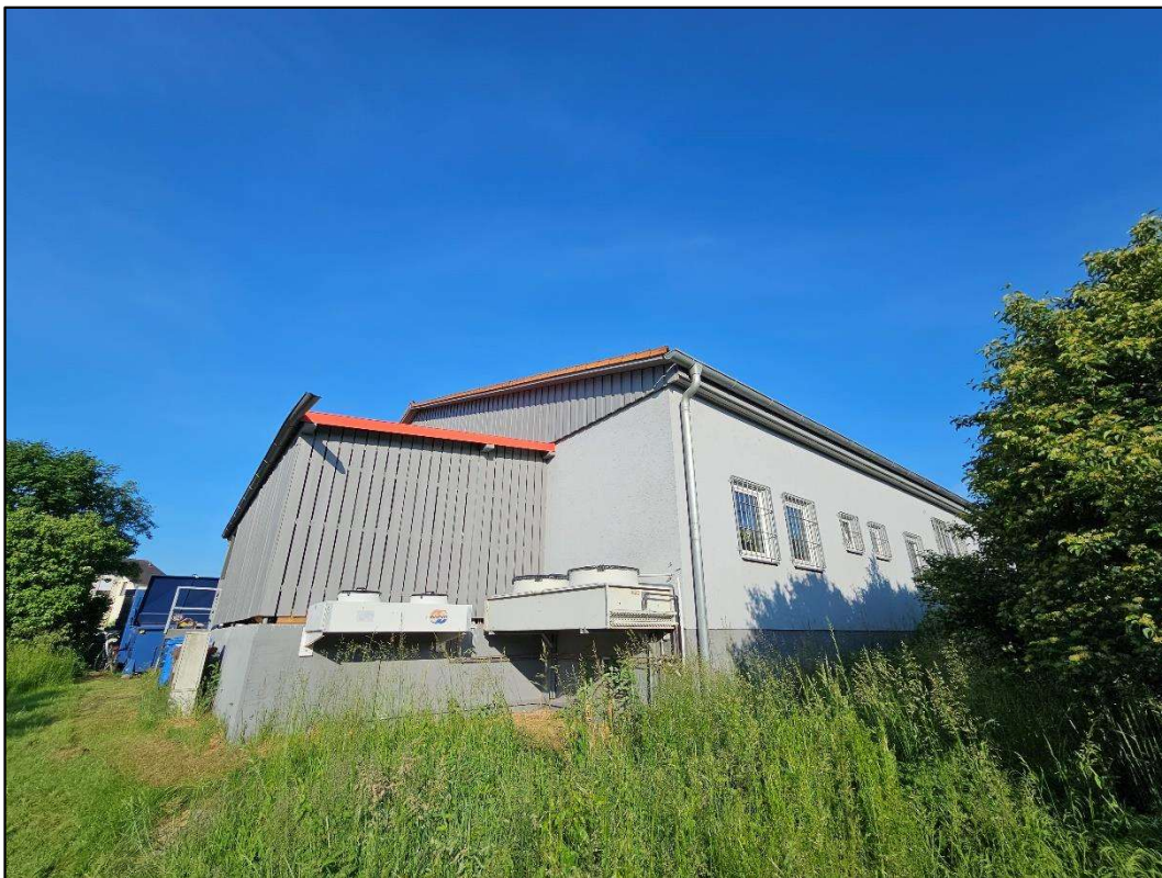
Abbildung 36: Nordöstliche Ecke des EDEKA-Markts. Blick Richtung Südwesten.
