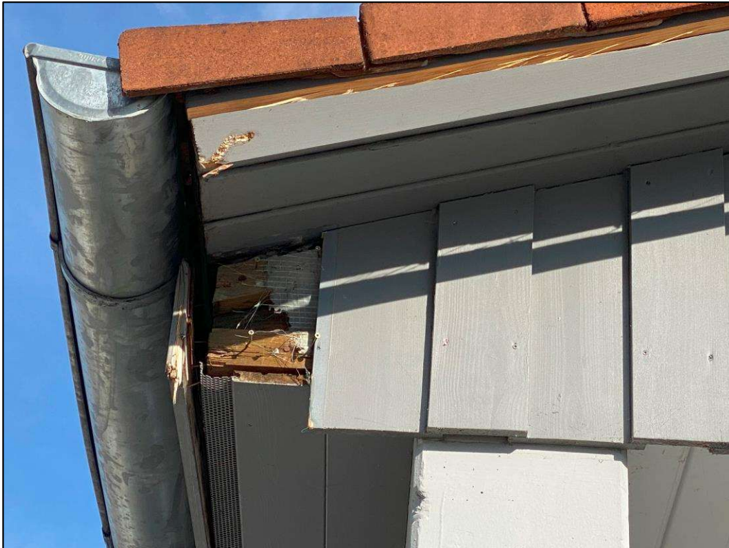
Abbildung 33: Nische für Gebäudebrüter an südwestlicher Ecke des EDEKA-Markts.
