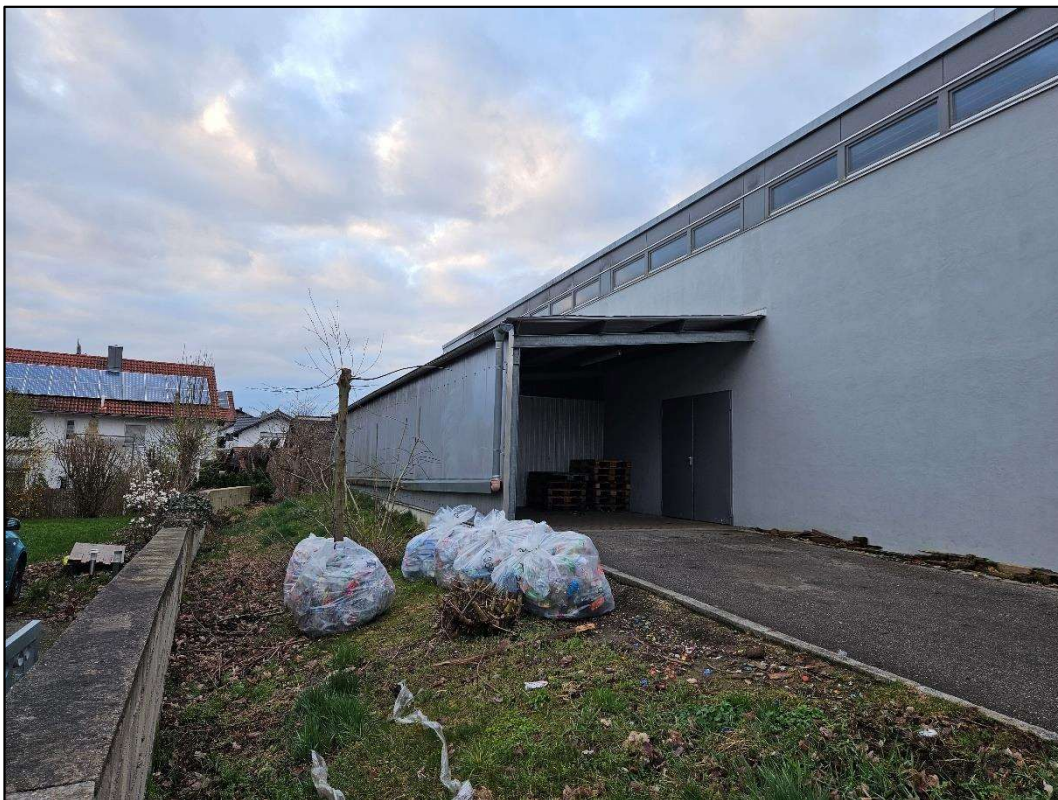
Abbildung 26: Nordseite des westlichen EDEKA-Gebäudes mit Grünstreifen. Blick Richtung Westen.
